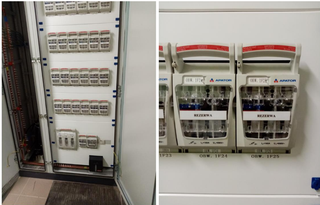
Rys. nr 2. Widok rozłączników bezpiecznikowych w polu nr 3 rozdzielnicz głównej.
