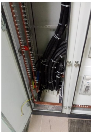
Rys. nr 3. Widok wyprowadzenia przewodów w/z na poziom piwnicy z rozdzielnicz RGN-B, pole nr 3.
